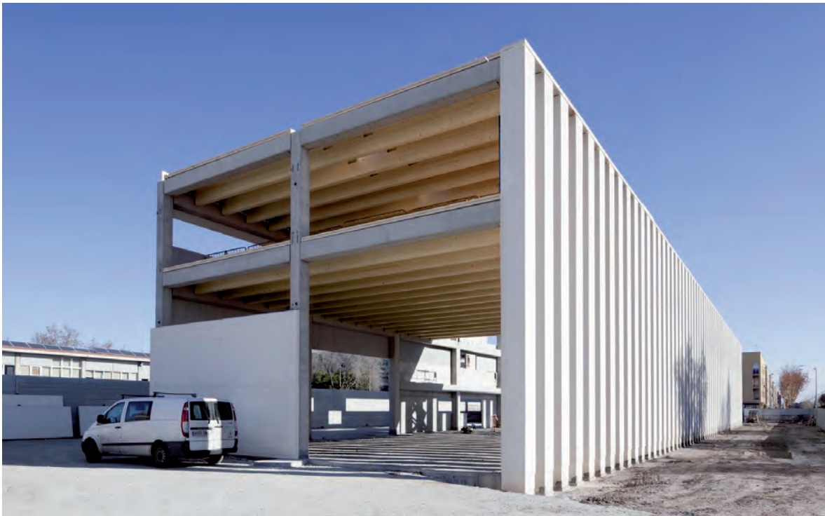
Weit gespannte KLH-Rippenelemente und schattenspendende Stahlbetonstützen
