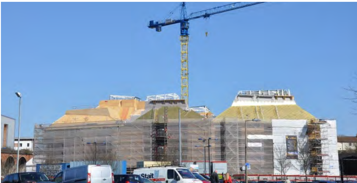
Worcester Library, UK: Einsatz von KLH-Hohlkastenelementen für Dachelemente mit großer Spannweite
