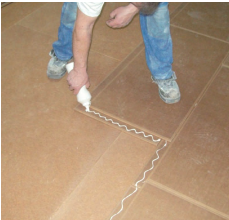
Einbau des Silencium Gold Systems
