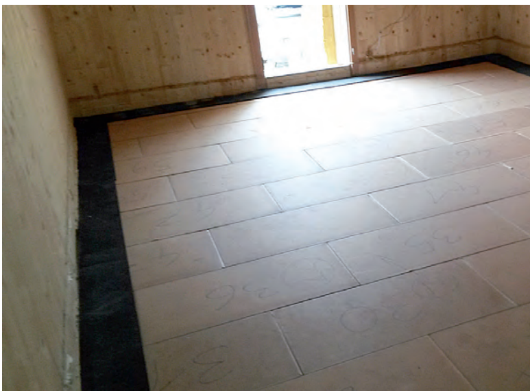
Prüfaufbau mit Schallfresser Trockenestrichelementen im Deckenprüfstand der Fa. KLH
